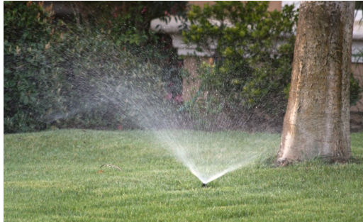
Revisa que los aspersores no tengan goteras
